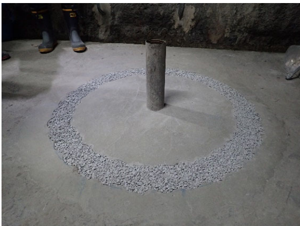
粘土止水壁の施工完了の様子
