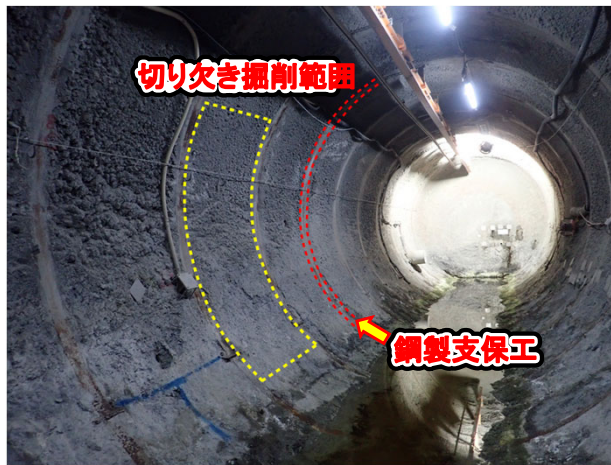
掘削前の試験坑道2の様子
