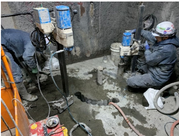
円周上への溝の掘削
