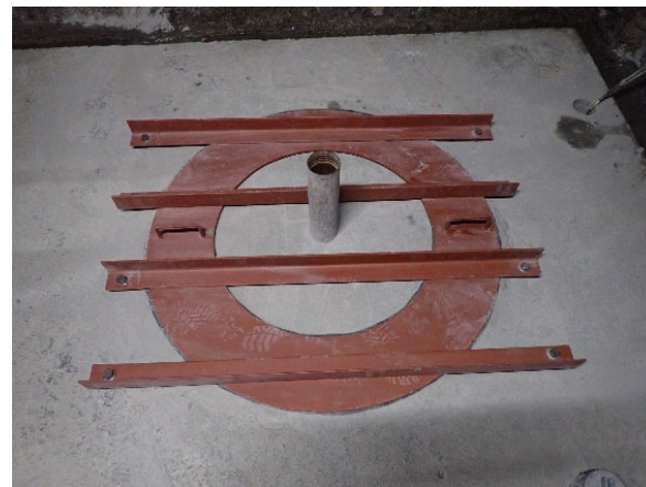
ペレット膨出抑制の蓋の設置
